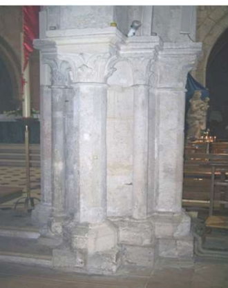
A la croisée du chœur : gros pilier cylindrique, flanqué de quatre colonnes octogonales appliquées et de trois fûts circulaires, comme à Chartres, alors en construction.
